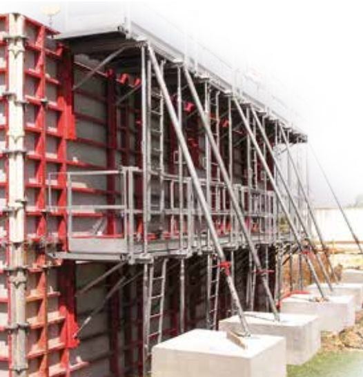
StarTec-Securit mit integriertem Sicherheitszubehör und Betonierbühne
