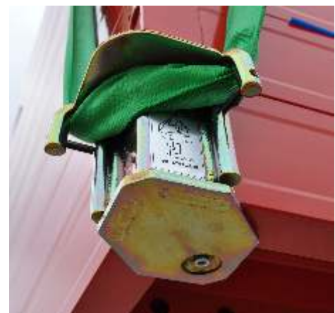
▲ Detail: eingebautes Transportgehänge am Elementstapel
