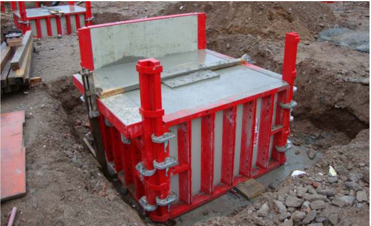
Bei Fundamenten ein großer Vorteil: Die Elemente der Ultramax sind von Hand einsetzbar.
