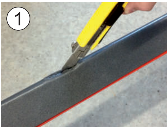
▲ FLUXX F6 Folie an den Aussparungen einschneiden
