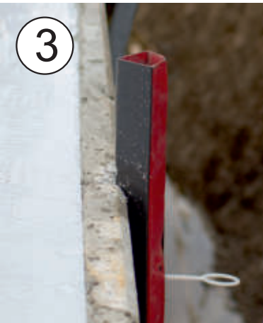
◀ FLUXX Abschalschiene in der Fuge arretieren
